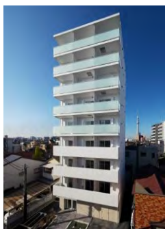
アイル イムーブル押上 （墨田区）
