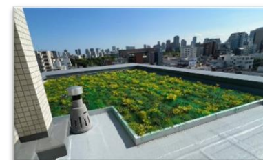
当社開発PJにおける 屋上緑化事例 ▶
